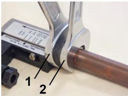
Abb. 11: Gerät einschrauben
