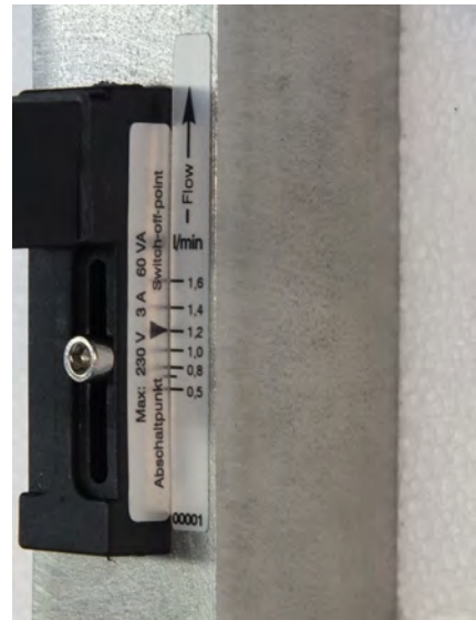
Abb. 35: Schaltwert ablesen (Beispiel- skala)
