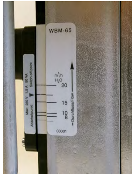
Abb. 34: Schaltwert ablesen (Beispiel- skala)
