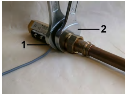
Abb. 12: Gerät einschrauben
