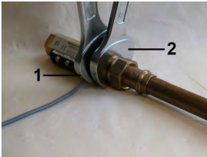
Abb. 11: Gerät einschrauben
